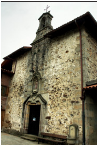
Fachada exterior de la ermita.
