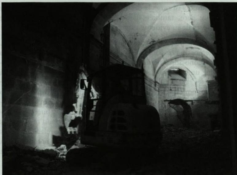
Ilustración nº 14: Fotografía tomada desde aproximadamente el mismo punto de vista que la nº 13, seis meses después. Recuperación de la geometría original por la demolición del forjado impropio de hormigón y las adherencias folcloristas.
