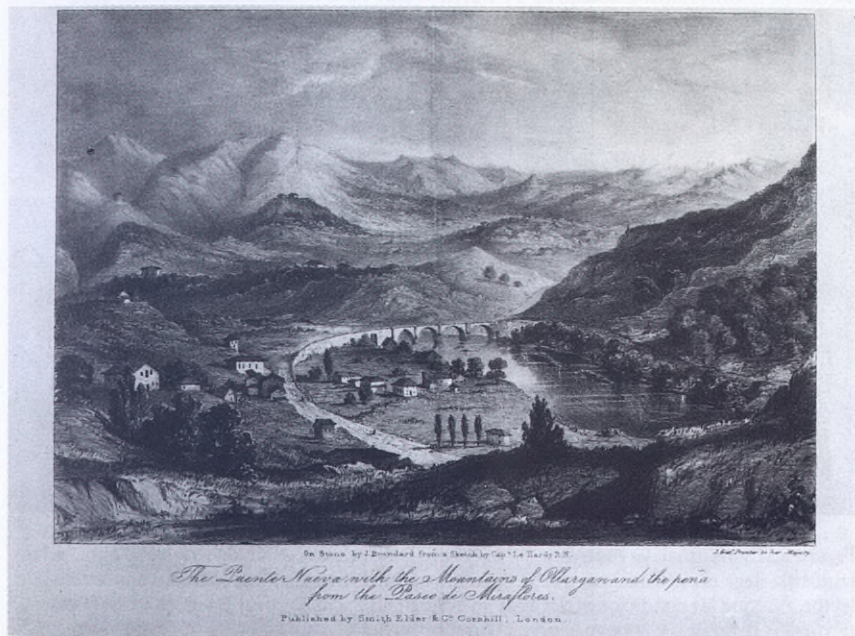
Figura 1. Huertas, edificios y caminos fueron las primeras ocupaciones de los terrenos del río por el hombre. Cuenca Ibaizabal-Nerviión. El Puente Nuevo que daba paso a la Villa de Bilbao por Bolueta y Miraflores. Mediados del siglo XIX.
