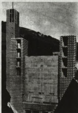
2. Friso de Aránzazu vacío durante su construcción
