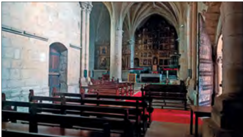
Fig. 3b. Imagen reciente del interior de la iglesia en la que se aprecia la posición de la puerta del s. XIII, interrumpiendo la moldura superior de la pared. Encima de ella se encontraba el órgano. (Fotografía de I. Llarena).
