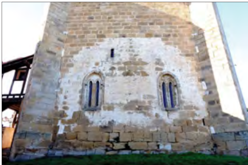
Fig. 17. San Martín de Askizu, fachada oriental, con su par de ventanas medievales geminadas y las huellas preservada por un irreductible lucido de cal que declara el piñón de un edificio más bajo, pero no se extiende a los inmediatos contrafuertes
