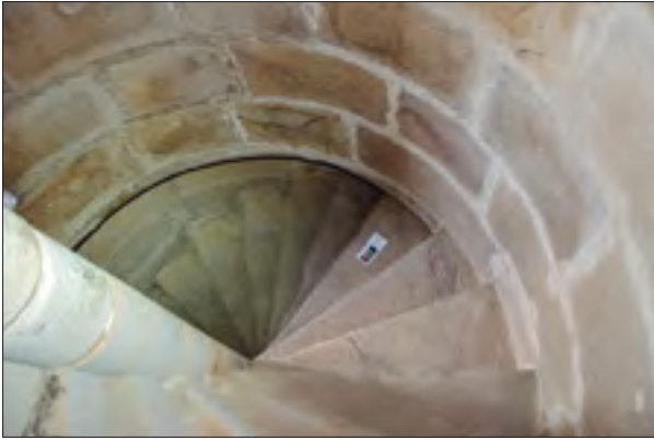
Fig. 22a. Escalera helicoidal, a derechas, de subida al campanario, vista desde arriba. (Longitud máxima de la escala 14 cm). (Fotografía de K. Lizarraga).
