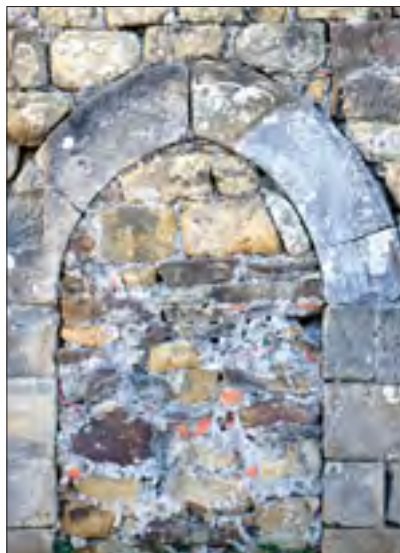
Fig. 12. San Martín de Askizu, puerta plana y tapiada, entre el aparcamiento occidental de vehículos y el pórtico meridional.
