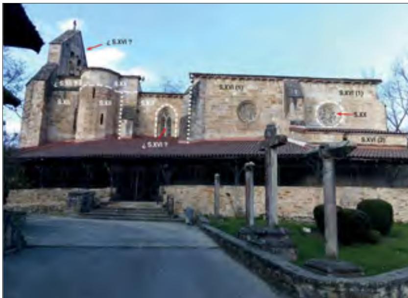
Fig. 35. Hipótesis acerca de la evolución del edificio de la iglesia de Andra Mari, en la que se han conservado tres partes de tres iglesias de épocas diferentes. A la izquierda, al oeste, la del s. XII, incluyendo el campanario y la torre de subida; en el centro, la del XIII, que en su parte inferior contiene la portada y a la derecha, al este, la ampliación del s. XVI, con la cabecera. (Fotografía de X. Orue-Etxebarria y diseño de F. Caballero).
