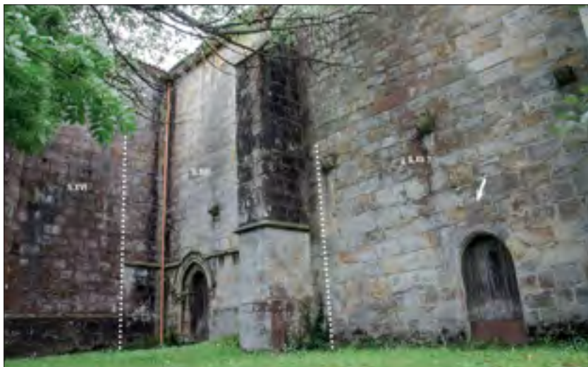
Fig. 14. Aspecto del lado norte de la iglesia de Andra Mari, a la izquierda, al este, estaría la cabecera. Se puede apreciar donde se ha marcado el límite entre la parte ampliada del s. XVI y la pared del s. XIII con la puerta ornamentada, a la izquierda del contrafuerte. También se observa donde hemos señalado el límite entre la pared del s. XIII y la del hipotético s. XII, justo después del contrafuerte, a la derecha. La puerta que aparece a continuación, señalada con una flecha, no está ornamentada. (Fotografía de K. Lizarraga y diseño de F. Caballero).
