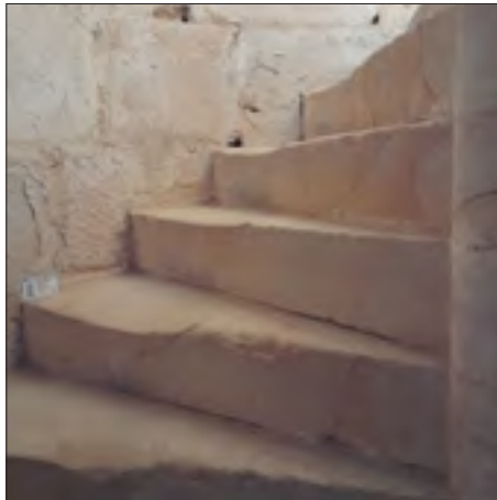
Fig. 22b. Aspecto de la escalera helicoidal a derechas que asciende hasta la bóveda y el campanario. Cada uno de los escalones corresponde a una pieza única. (Longitud máxima de la escala 8,5 cm). (Fotografía de X. Orue-Etxebarria).
