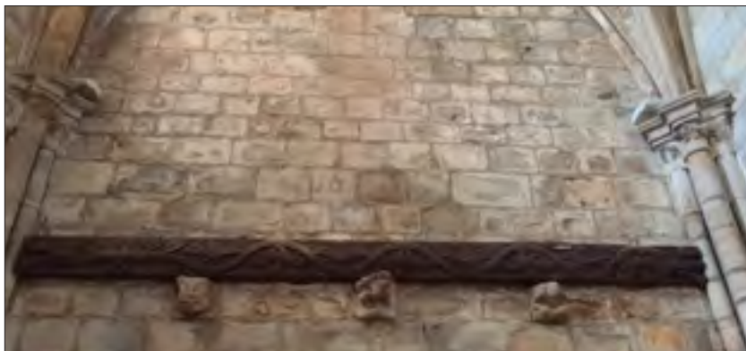
Fig. 16. Modillones existentes en la pared interna del muro del campanario, a los pies del templo que, en nuestra opinión, se encuentran en el tramo del s. XII. Su parte superior plana sujetaba el suelo del coro y, quizás, también el suelo de la primera planta de la fortificación del s. XII. (Fotografía de E. Apellaniz).
