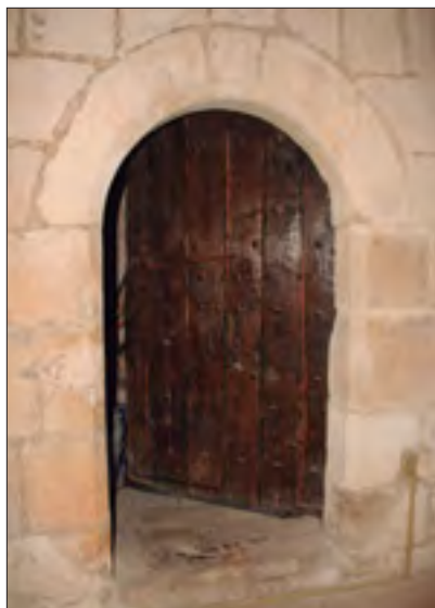
Fig. 24. Puerta de acceso a la escalera de subida de la torre, con arco de medio punto, en el tramo IV del lado sur. (Fotografía de K. Lizarraga).
