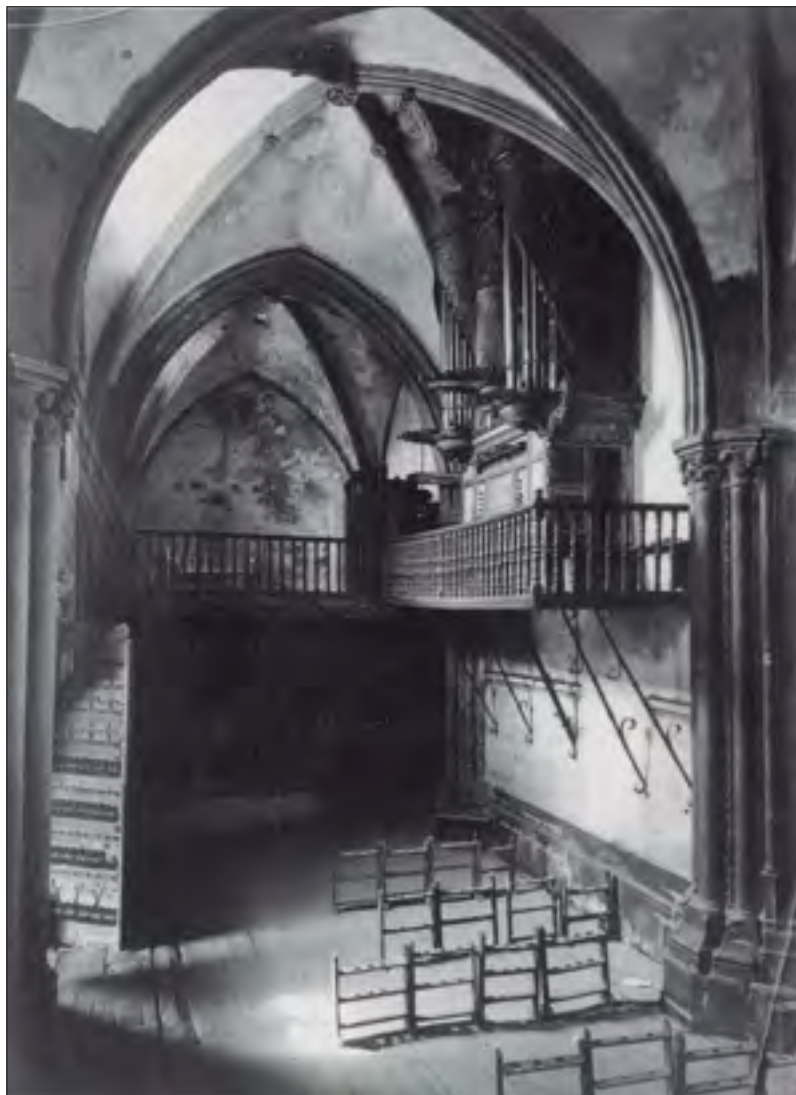
Fig. 3a. Puerta del s. XIII tapiada, en el interior de la iglesia, por el lado norte, que se encuentra debajo de donde está el órgano y enfrente de la entrada principal. La interrupción de la moldura en la pared nos indica donde se encuentra la puerta. En esta imagen, de la primera mitad del s. XX, también aparecen dos elementos importantes de la iglesia, el coro, al fondo, a la izquierda y el precioso órgano a la derecha. Este último se construyó en 1744.
