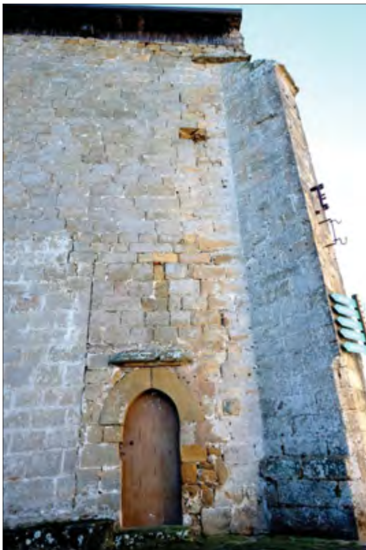
Fig. 13. San Martín de Askizu, fachada septentrional, tramo occidental, con su puerta plana, plenamente rural, azarosamente aparejada con las fábricas colindantes.
