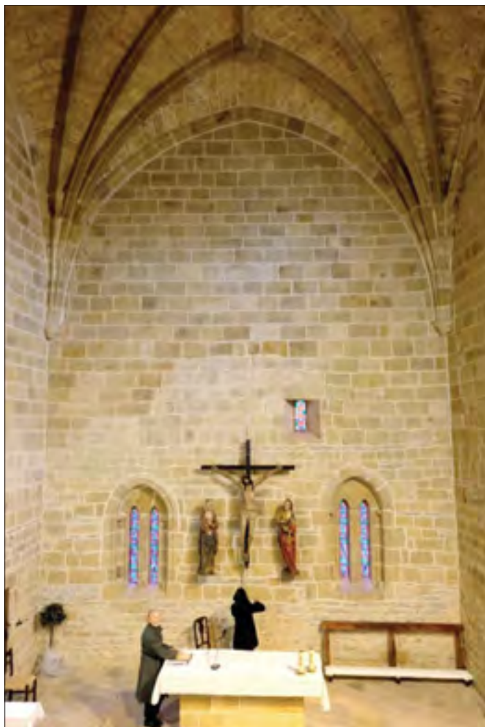
Fig. 30. San Martín de Askizu: Aparejos interiores del testero oriental, con la huella del piñón medieval y las hiladas de lajas interpuestas para ir encajando los sillares del recerco de las ventanas.
