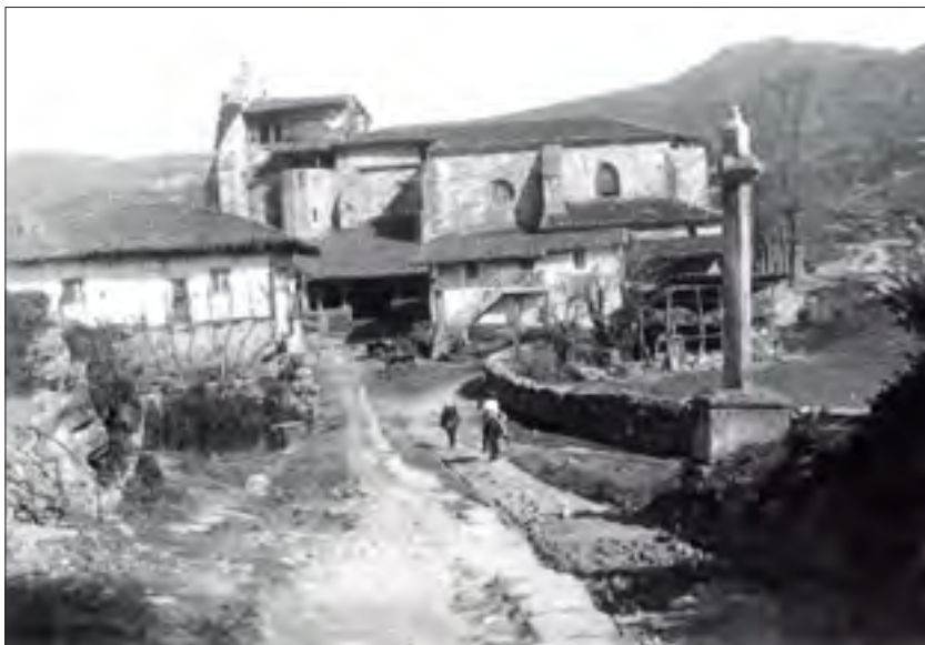
Fig. 30. Imagen de 1930. En la parte superior de la iglesia se observa el entramado de madera con el reloj que se hizo en 1604. El edificio que se aprecia a la izquierda es la antigua casa cural. La torre de subida en el tramo IV, cerca del campanario y la ventana apuntada a la derecha, en el I, aparecen tal como estaban antes de ser modificadas. A la derecha se aprecia una de las cruces del “vía crucis” que iban a la iglesia. En el centro restos de la “calzada” o “andabide”, una de las tres que se dirigían a la iglesia. Otro, que venía desde Isasi, discurría por detrás de la cruz que está a la derecha y por delante de donde están los dos burros. El tercero venía del barrio de Egia y pasaba por la izquierda de la casa cural.
