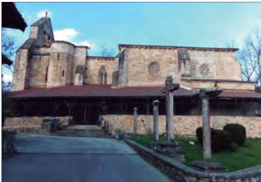
Fig. 1. Imagen de la magnífica iglesia románica de Andra Mari de Galdácano. De ella se pueden destacar, a primera vista, su tamaño, su construcción en sillería y su aspecto de solidez. (Fotografía de X. Orue-Etxebarria).
