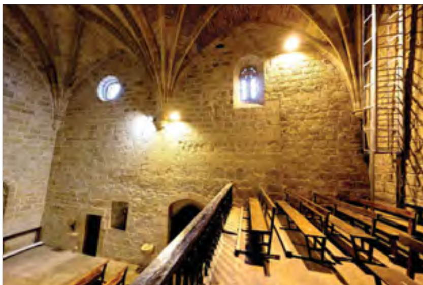
Fig. 33. San Martín de Askizu: Paramento interior del muro sur, desde el coro. Obsérvese las dos llagas rectilíneas: La que se halla entre el arco fajón y el ventanal geminado, que señala la respnsión de la bóveda sobre el presbiterio, y el que, un metro a la derecha de la misma ventana, asciende verticalmente hasta alcanzar el nivel de su alféizar y señala la longitud del templo medieval.
