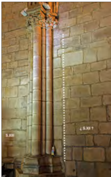
Fig. 15. Contacto irregular entre sillares del tramo IV, a la derecha y del III, a la izquierda, en la pared sur del edificio, entre la puerta principal y la de entrada a la torre. En esta pared solo se observan cuatro columnas y lo más lógico es pensar que haya una quinta a la derecha, que ahora no se ve, porque probablemente está englobada en el muro. (Fotografía de K. Lizarraga y diseño de F. Caballero).
