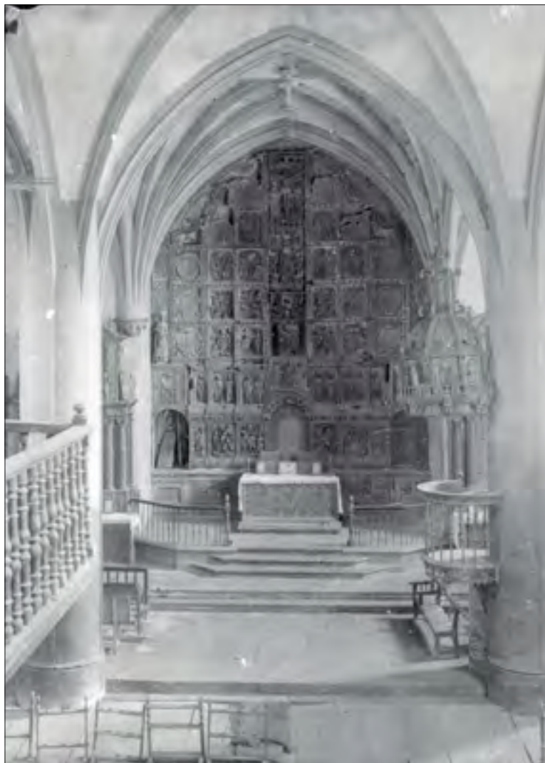
Fig. 6. Imagen de la primera mitad del s. XX, en la que se puede apreciar el suelo entarimado, situado en la parte inferior de la misma, hasta el comienzo de las columnas y del primer escalón. Más o menos, en el centro de esa zona, donde hay unas maderas más oscuras, muy cerca del escalón, se encontraba la tumba de Don Sancho cubierta por unas tablas. Al fondo el retablo, antes de su restauración y a la derecha el púlpito, y encima de él, el tornavoz o sobre púlpito.
