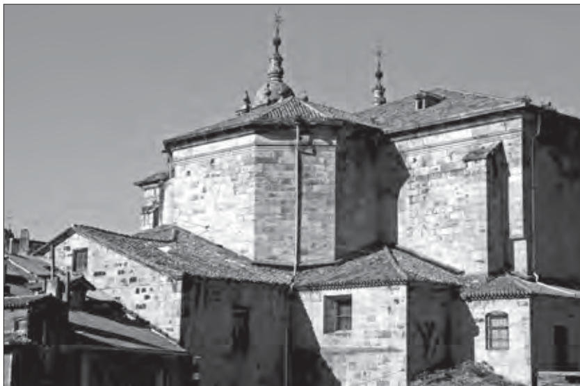
Fig. 8. Frente oriental de Santa María, expuesto a la luz escrutadora de la mañana, con el volumen de su gran ábside destacando en el centro de su muro oriental. Los muros del templo están labrados en excelente sillería de piedra arenisca, que destaca cromáticamente sobre los muros de albañilería de las casas vecinas. Obsérvese, bajo el cielo azul, en el ápice de su muro más oriental, sobre la cubierta de la adyacente casa vecinal de ladrillo, tras de unas chimeneas, la presencia de la ventanita centrada en el piñón, abierta al insólito nivel de los aprovechamientos de bajo cubierta. Es la del “transparente”.
