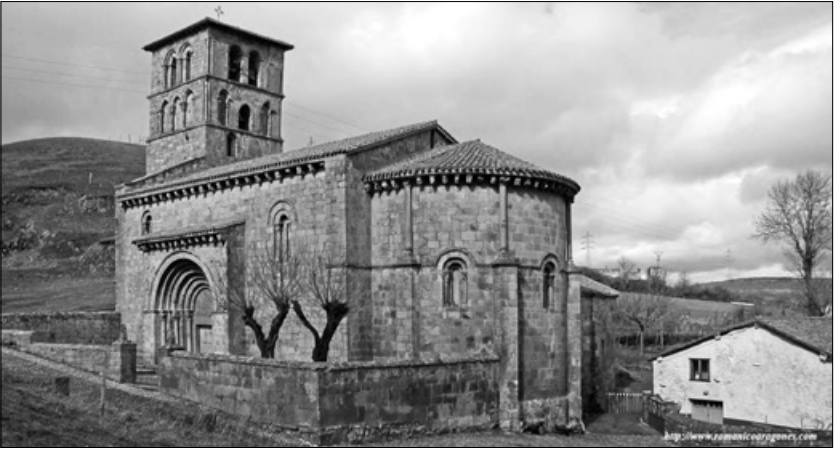
Fig. 3. Un templo románico del siglo XII: La Colegiata de San Pedro de Cervatos (Cantabria). Obsérvese cómo el muro que rodea la portada se adelanta, aumentando el espesor del muro para permitir el refuerzo de la delicada apertura del vano y, con ello, un mayor desarrollo de las arquivoltas. El regrueso resultante se resuelve perimetralmente en forma de alfiz enmarcando la bocina de arquivoltas.
