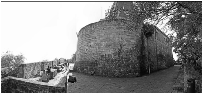
Fig. 12: La plataforma superior del revellín, el cubo, y sus dependencias anexas.
