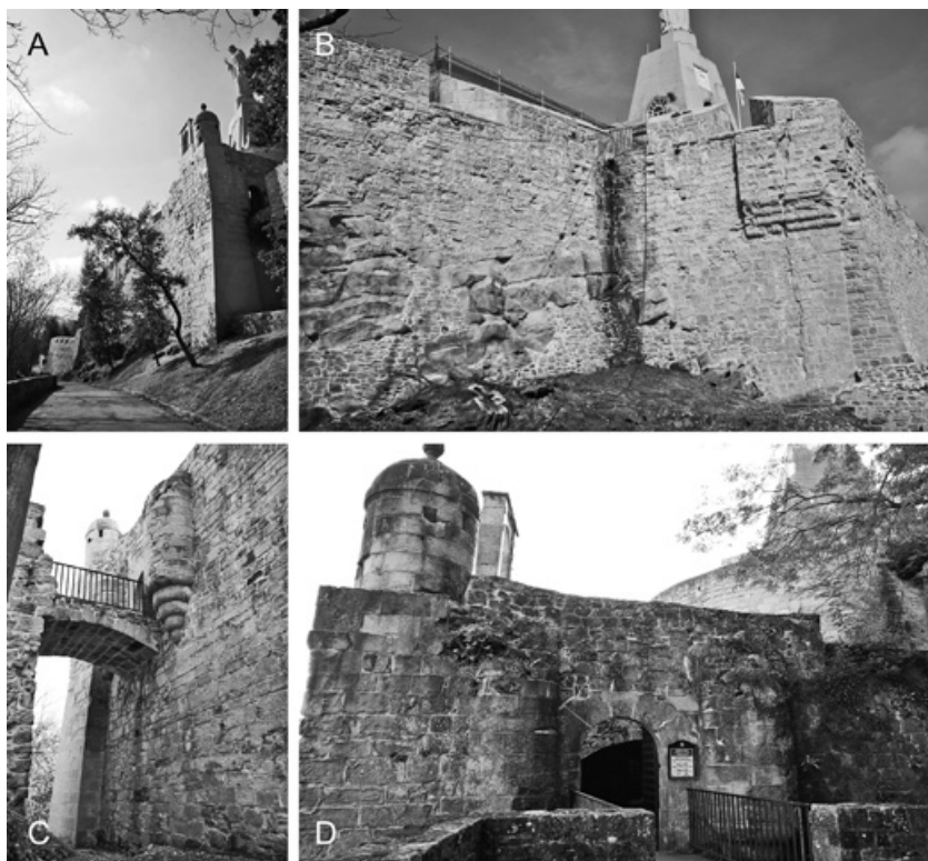
Fig. 14: A y B) El revellín y las torres con adarve amatacanado sur y este (1548-50). La estructura, apoyada sobre la roca recortada, amenazó ruina, y las torres citadas tuvieron que ser reforzadas con un contrafuerte. El pretil y troneras son posteriores. C y D) Acceso este al revellín (1548-50), aún conserva la parte inferior de sendas escaraguaitas que lo flanqueaban, así como la huella de las aberturas para izar el puente levadizo.
