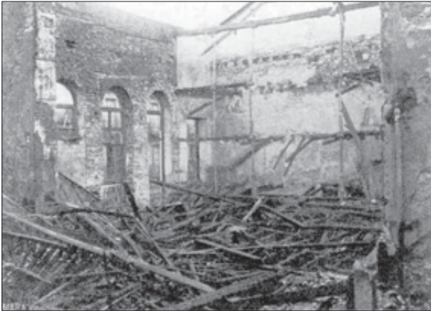
Fig. 10. Incendio Bellas Artes en 1913.
