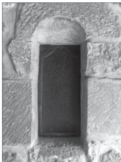
Ventana del caserío Iregi, recuperada del antiguo convento.
