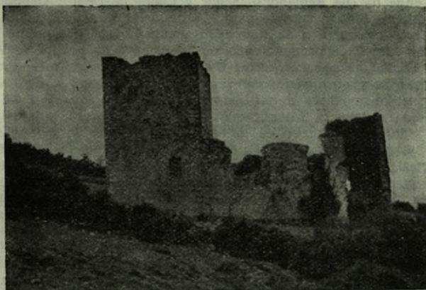
Estado actual de la torre y palacio de Guevara
