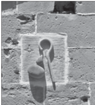
Detalle en una fachada de la iglesia del Juncal, Irun. Origen de los caminos por Gipuzkoa.
