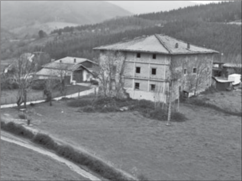
Caserío Zabaleta. A la izquierda, la ermita de San Sebastián, transformada en almacén.
