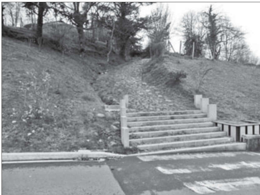
El camino de Santa Bárbara, cortado por la nueva carretera, vemos perfectamente el empedrado del camino real. Se prioriza el paso peatonal por el viejo camino (paso de cebrá más escaleras de acceso). Urretxu.
