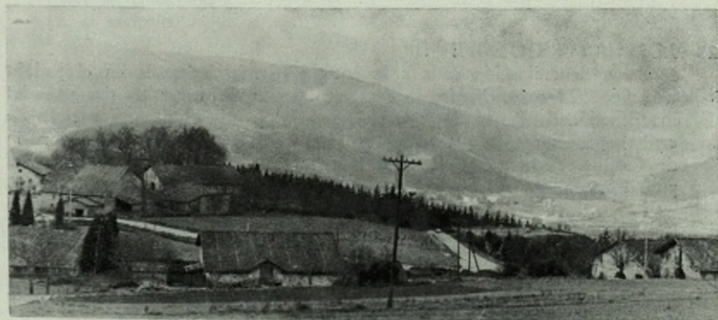
Caserías del barrio de BERRIO. — Fotografía tomada desde la carretera que sube al puerto de Elgueta.
