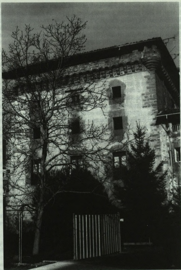
Lámina, 3. Torre de La Puente, rehecha en 1675
