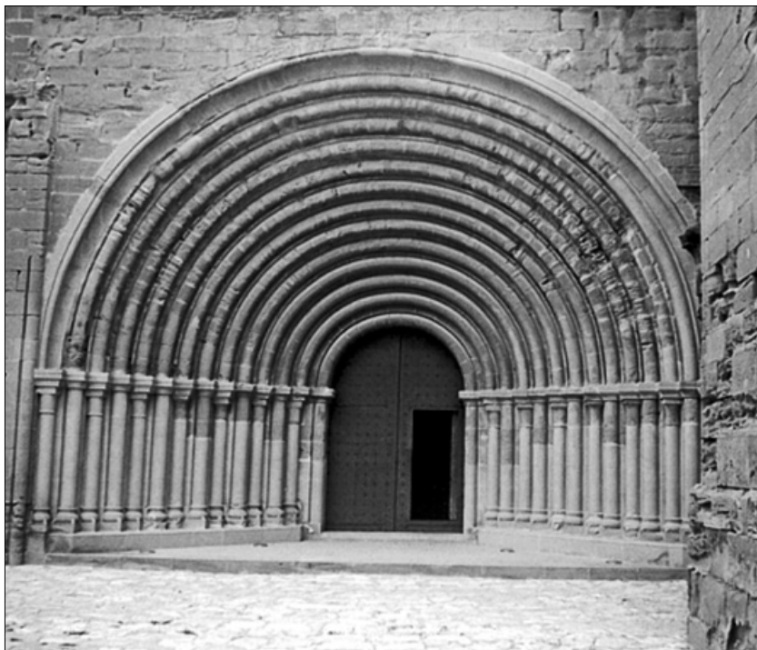
Fig. 5. Portada abocinada de la iglesia en el Real Monasterio de Sigüenza (Huesca), simplificada por la ausencia de tímpano pero con un enorme desarrollo de arquivoltas, esta vez romanizantes por ser de medio punto y proclamadoras de la riqueza de su alta promoción en 1188, nada menos que la reina doña Sancha de Castilla, esposa de Alfonso II de Aragón.
