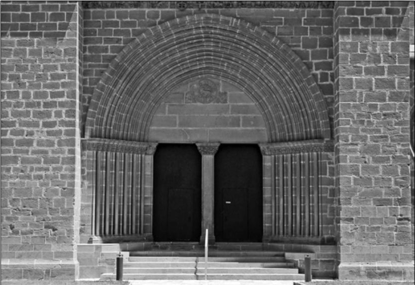
Fig. 2. Monasterio de La Oliva (Navarra), uno de los primeros edificios góticos construidos en tierras hispanas: Puerta occidental del oratorio, de hacia 1300, cuajando el ámbito estrictamente cuadrado enmarcado por los contrafuertes y con un tímpano casi desnudo (la provocativa austeridad cisterciense) aureolado por una poderosa bocina de arquivoltas ampliamente desarrollada (la prepotencia y los medios de la Orden).
