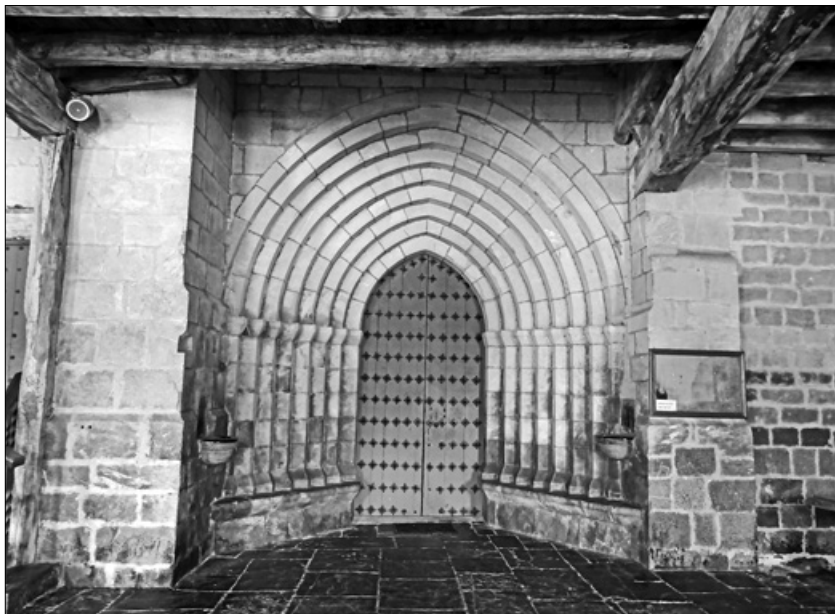
Fig. 9. Berástegui. Una portada con ambiciones de grandiosa y que probablemente lo sería más en su probable emplazamiento anterior, presidiendo la fachada occidental del templo. Hoy la hallamos desplazada y, sobre todo, constreñida entre los poderosos contrafuertes que contrarrestan las bóvedas de la edificación moderna.
