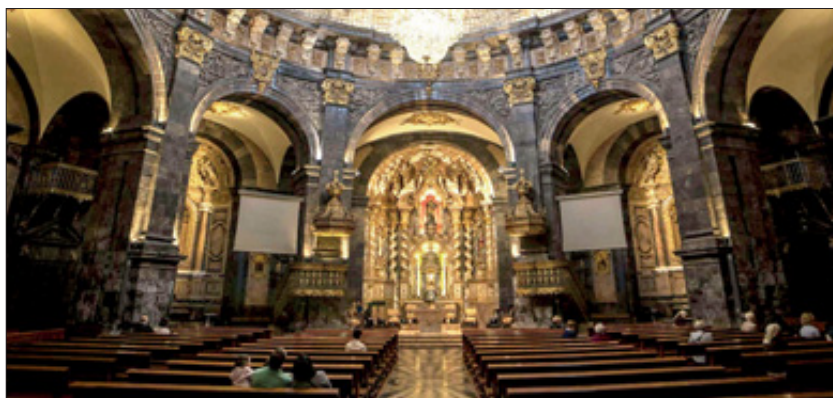
Fig. 25. Interior de la basílica, con el Altar mayor y la estatua de plata del Fundador. En primer término, la engañosa apariencia dada a las bóvedas de los pasos, con arcos que quieren parecer semicirculares, pero son en realidad semielípticos, con las claves a la misma altura pero más amplios los exteriores, lo que obliga a singularizar la labra para cada dovella en todos ellos.
