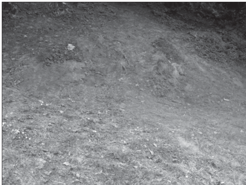
Fig. 4. Situación de deterioro actual en las inmediaciones de la cueva.
