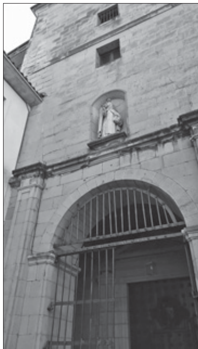
Torre baja y entrada a la iglesia.
