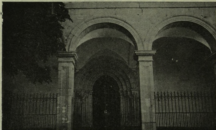
Fig. 3. El pórtico en su estado actual.
