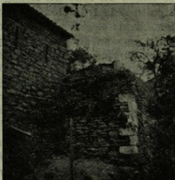
Fig. 3.—Vitoria. La muralla antigua Cubo N.º 1.
