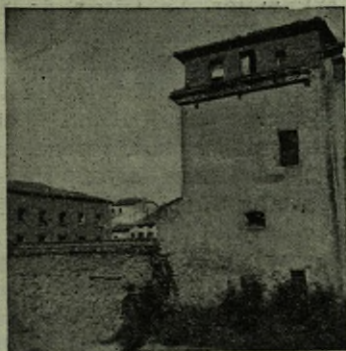
Fig. 10.—Vitoria. La muralla antigua.
