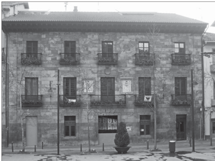
Lámina 16. Fachada principal del palacio Corral-Ipeñarrieta.
