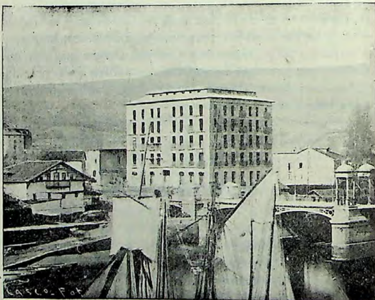
La casa de Mazas en construcción y el puente, aún con ojo móvil, hacia 1860
