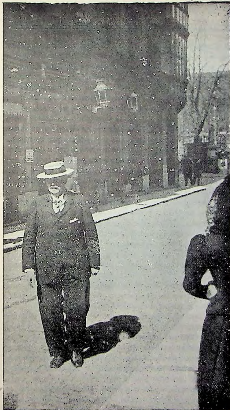
Pacho Gaminde frente a su tienda; al fondo, el pilar de la avellanera Fotografía tomada por el autor.—1895 En ella puede observarse, lo desnudo del arbolado del Arenal que indica la entrada cercana del invierno y a Pacho aún con sombrero de paja
