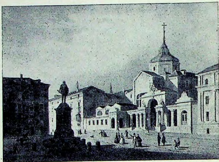
Antiguo edificio del Congreso de los Diputados, en el mismo emplazamiento que el actual Palacio de las Cortes
