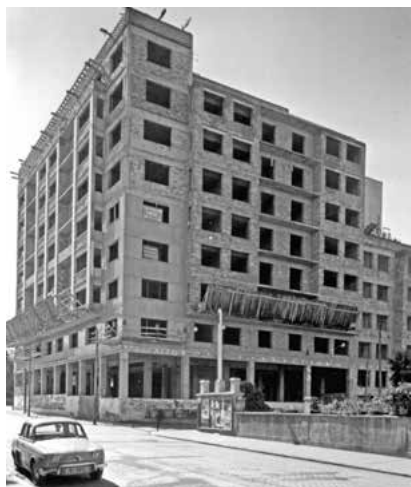
En construcción Dato, 1964. ATHA-SCH-PC-23520
