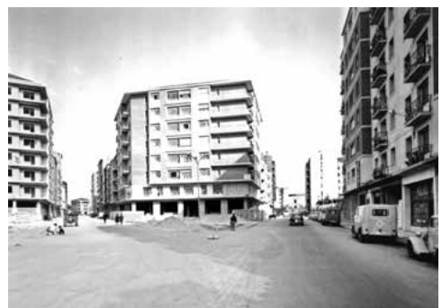
Edificios en construcción 1960-1970, C/Angulema-División Azul. ATHA.SCH.PC.24022
