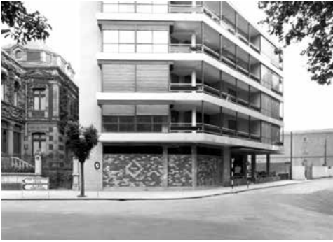
Nueva construcción C/Senda ATHA-SCH-PC24528
