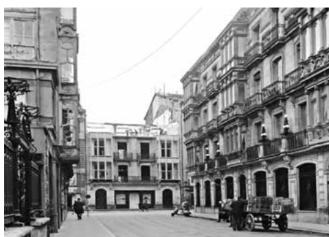
Calle General Álava, 1959. AHTA-SCH-PC-07561, derribando edificio calle Dato (sede del Banco Hispano- Americano) para abrir prolongación de General Álava
