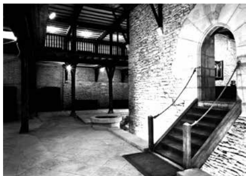
Rehabilitación Casa del Cordón, 1964. ATHA-SCH-PC-28446
